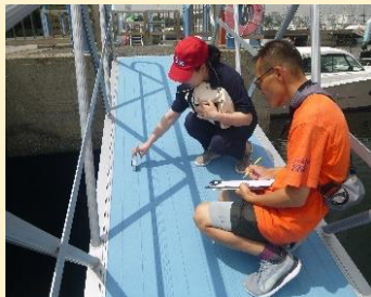
スロープ計測
